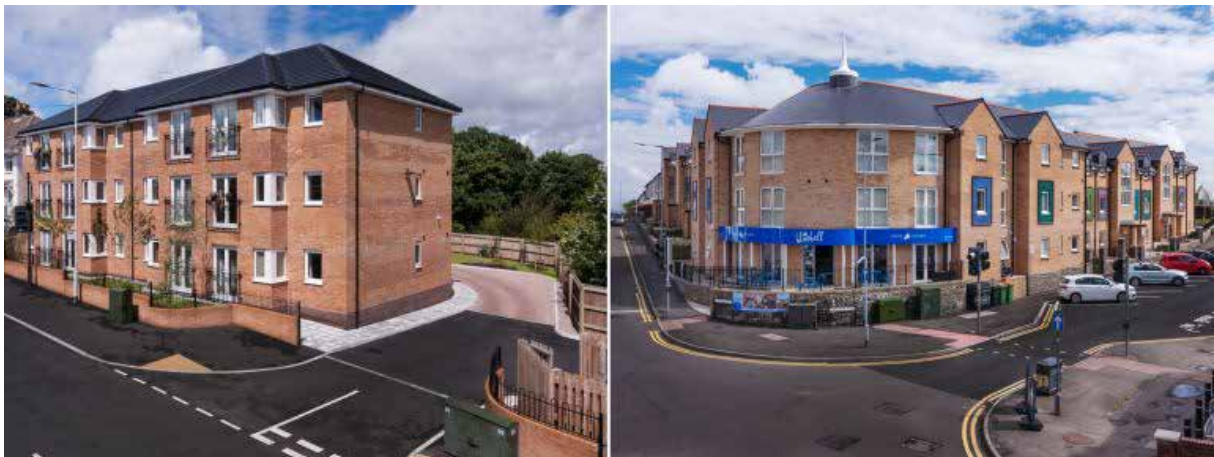
移転した小学校の校舎をアパートとして再開発したコースタル・ハウジング・グループによるプロジェクト。 同グループは現在、5500戸におよぶ住宅の所有・管理・賃貸を行っており、年間の新規住宅建設は200～300戸を数えています
