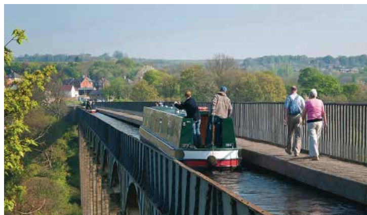
ポントカサステ水路橋と運河
